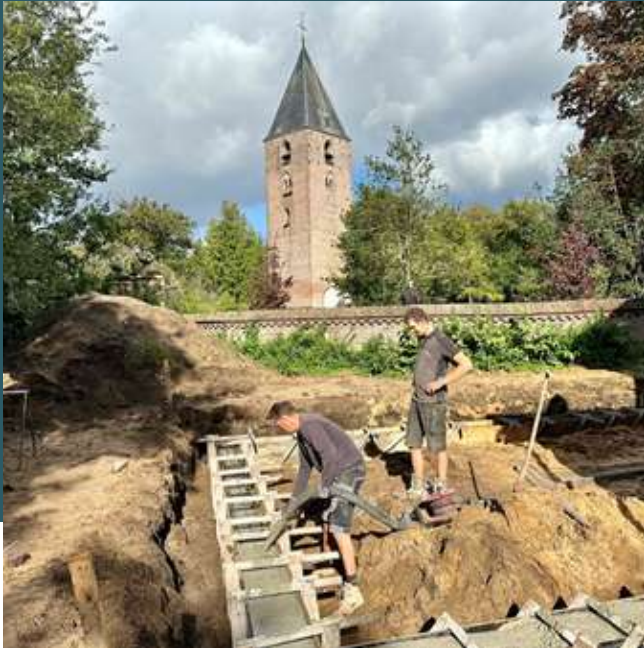
Het fundament voor de uitbouw wordt gelegd.
